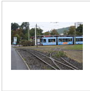
Gleisschleife am Hauptbahnhof mit GT-N am Abfahrtsbahnsteig stadteinwärts, nach links die Gleise zur Innenstadt
