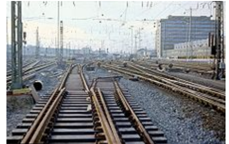
Umfangreiche Gleisarbeiten im Westkopf (Juni 1987)
