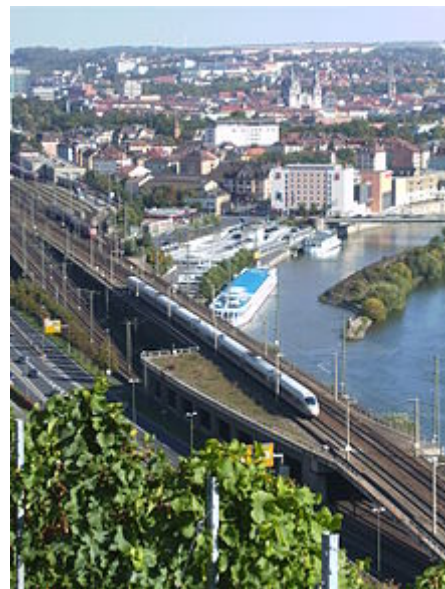
Ein ICE 3 fährt über die Rampe westlich des Hauptbahnhofs auf die Schnellfahrstrecke Hannover–Würzburg
