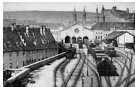
Blick von den Zufahrtsgleisen auf die Bahnsteighalle
