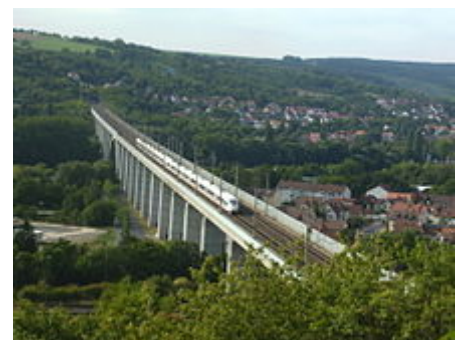
Bereits fünf Kilometer vom Hauptbahnhof Würzburg entfernt, auf der Maintalbrücke Veitshöchheim, erreichen ICE-3-Züge 200 km/h
