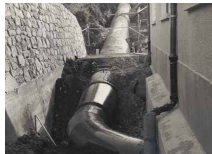
links Rohrleitungsunterbau
