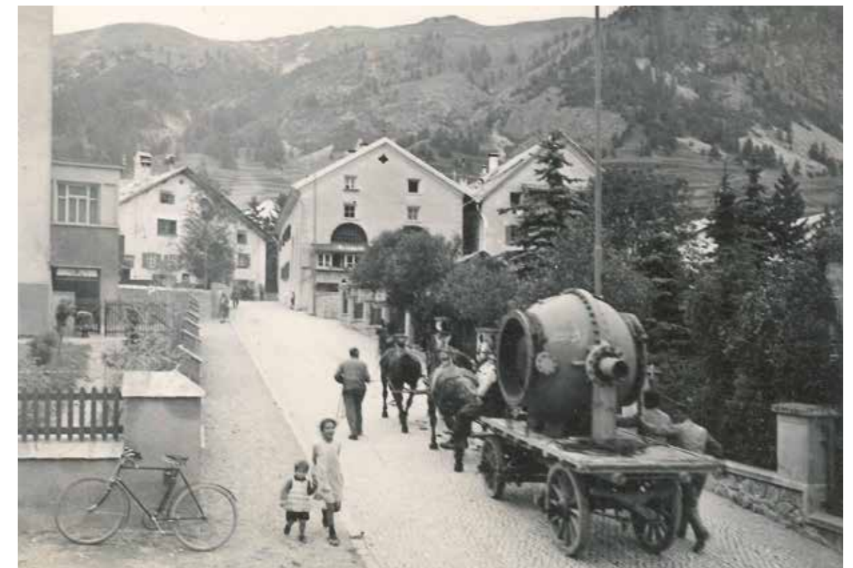
Transport der Drosselklappe für die Druckleitung Islas durch Samedan. Die Drosselklappe dient als Hauptabschluss bei Revisionen und als allfälliger Notabschluss bei Rohrbrüchen.
