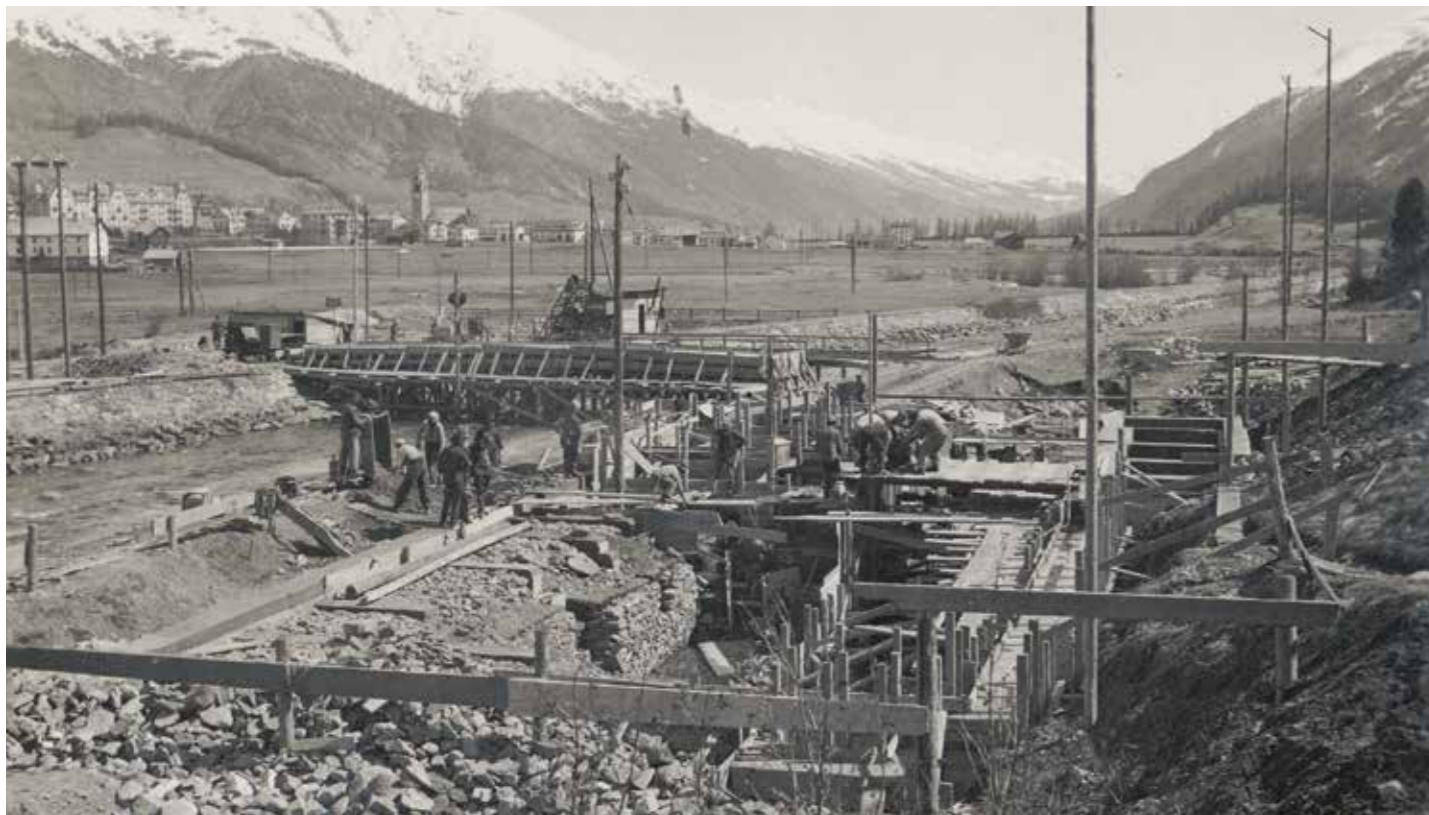
oben Das untere Ende der Druckleitung mit der Verankerung an einem betonierten Fixpunkt. Die Druckleitung wird nach Fertigstellung und nach vollzogener Druckprobe 0,5 bis 1 Meter hoch mit Erde zugedeckt. Die ganze Druckleitung samt Zentrale liegt auf dem Boden der Gemeinde Celerina.
