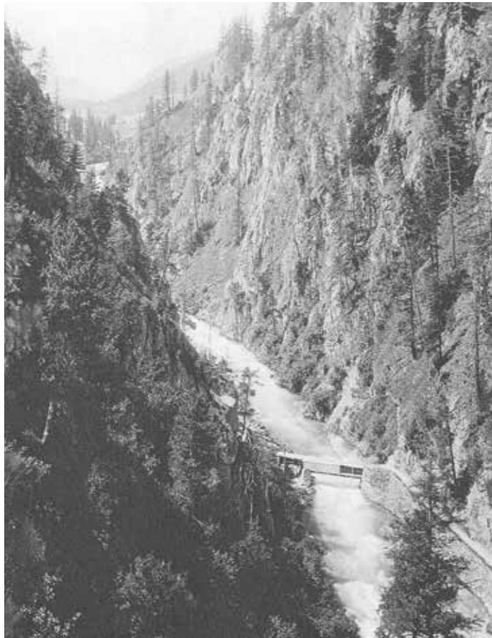
oben Wasserfassung auf Kote 1736 für die Zentrale Celerina.
