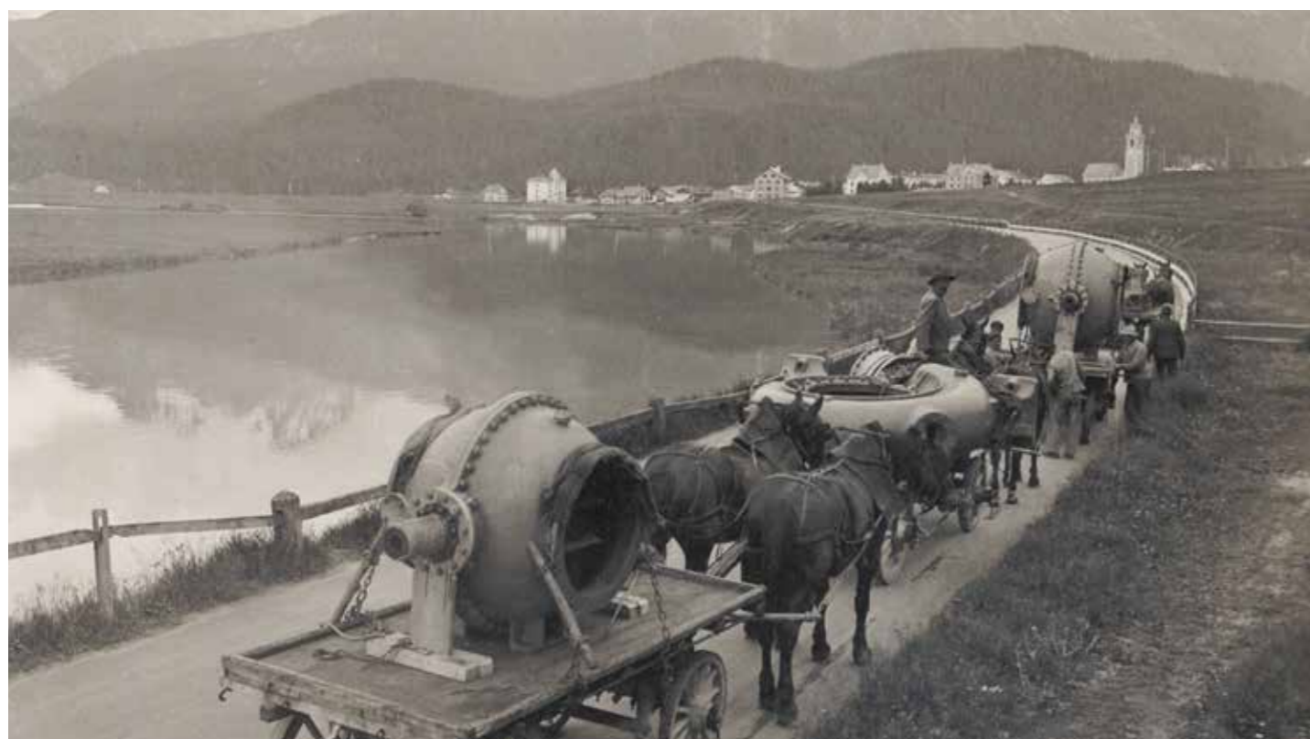
oben Transport der Druckleitungsrohre für den Bau der neuen Zentrale Islas. Obwohl das Fahrverbot im ganzen Kanton bereits 1925 aufgehoben worden ist, werden die Teile mit Pferden transportiert.
