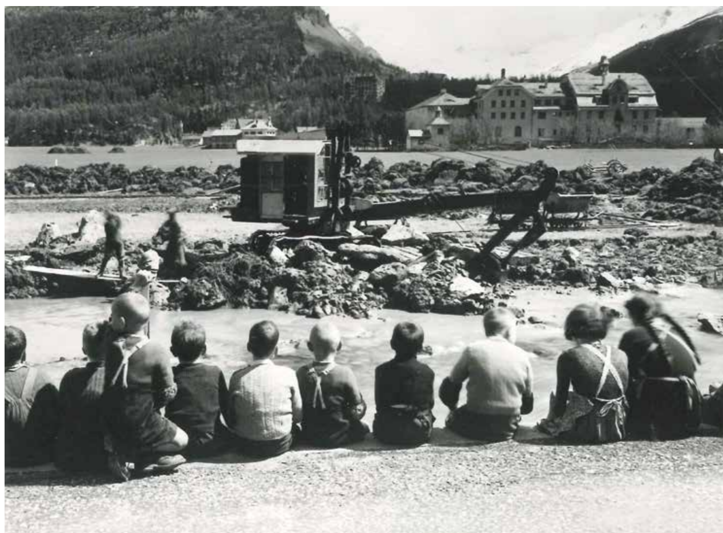
Die Bauarbeiten für die Nutzbarmachung des Silser- und Silvaplannersees beginnen im März 1947 und können im Oktober des gleichen Jahres abgeschlossen werden. Die maximale Bauintensität wies der Monat Juni mit total 110 Beschäftigten auf. Der Geschäftsbericht 1947/48 schildert das Vorhaben folgendermassen: «Zum Glück hatten wir alle den Mut, die Bauausführung im Frühling 1947 starten zu lassen. Wir haben indessen die Genugtuung erlebt, dass wir mit dem Bau im einzig möglichen Zeitpunkt loslegten, weder früher noch später wäre die Ausführung durchführbar gewesen! Wir hatten in allem grosses Glück, für das wir dankbar sein wollen. Wir wurden von der Natur unterstützt durch einen prachtvollen Bausommer, der seinesgleichen sucht.[...] Möge der gute Stern, der vom ersten Tage der Projektierungen im Jahre 1942 bis heute über diesem Gemeinschaftswerk gewaltet hat, der glückhafte Begleiter dieses Werkes bleiben!» Die erforderlichen Flusskorrekturen und Seeregulierungen kosten rund eine halbe Million Franken – hier ein Bild des Wehraufbaus in Champfer vom 23. Mai 1947. [37]
