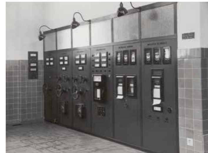
oben 23-kV-Schaltanlage
