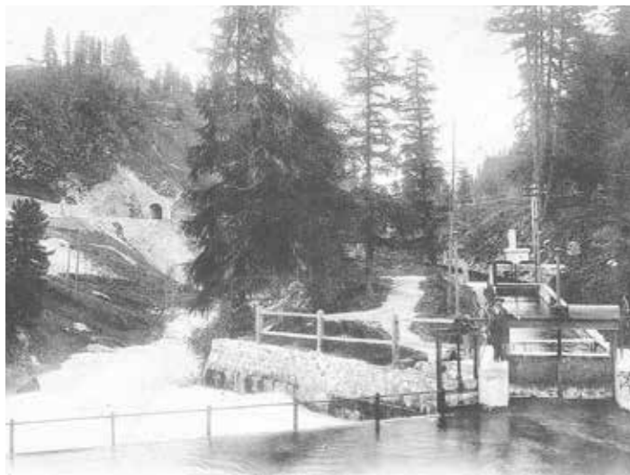
oben Das obere Kraftwerk Charnadüra mit dem Ablaufkanal im Vordergrund. Das weisse Haus im Hintergrund ist die Transformatorstation.
