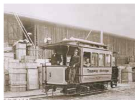
Probefahrt der elektrischen Strassenbahn St. Moritz auf dem Werkareal der Siemens in Nürnberg, Sommer 1895.
