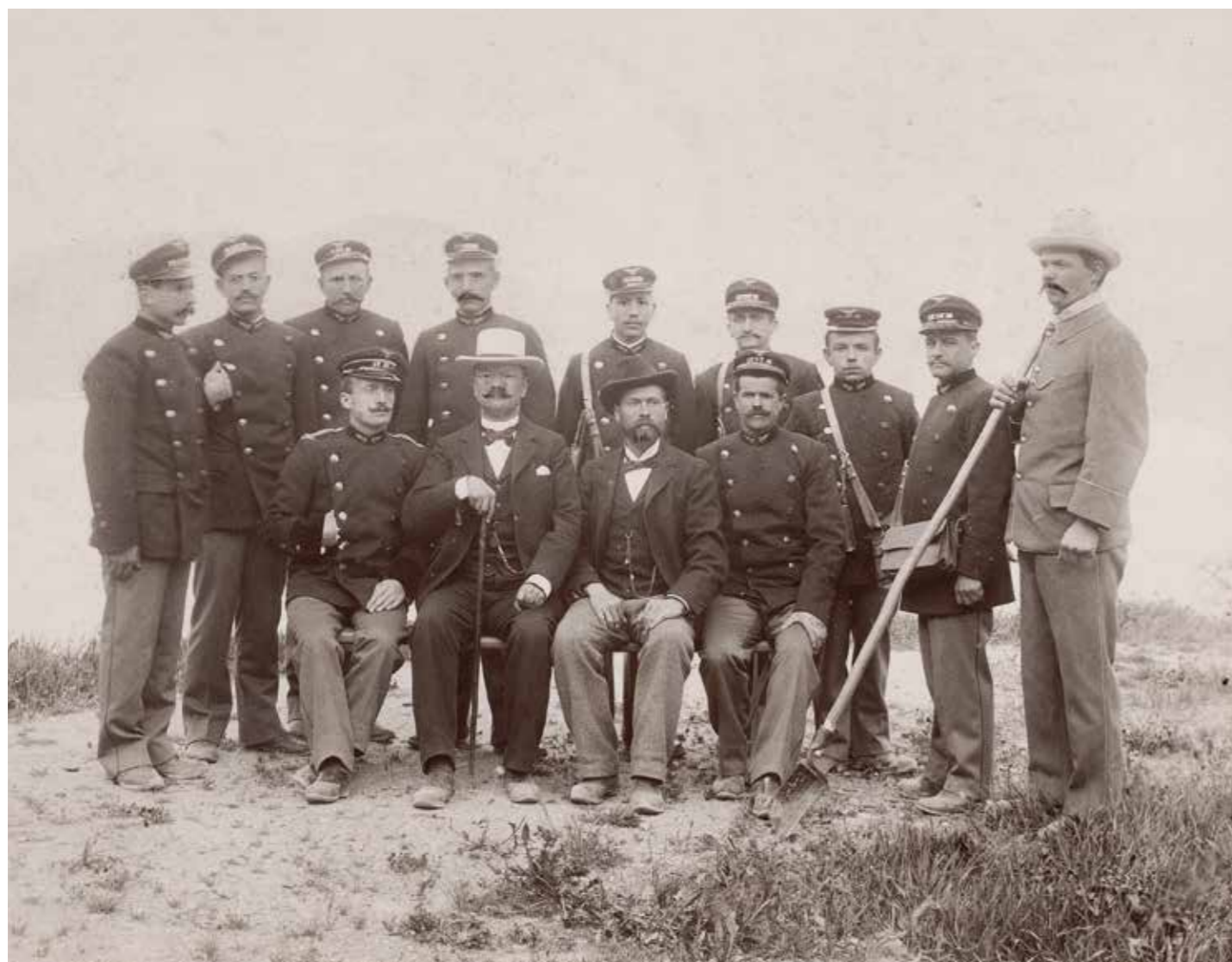
Die Bauarbeiten für die St. Moritzer Strassenbahn beginnen einige Jahre vor der offiziellen Inbetriebnahme. Hier die Mitarbeiter der Strassenbahn St. Moritz im Sommer 1892. Sitzend mit hellem Hut der Erbauer der ersten elektrischen Strassenbahn der Schweiz, Ing. Schuhmacher.
