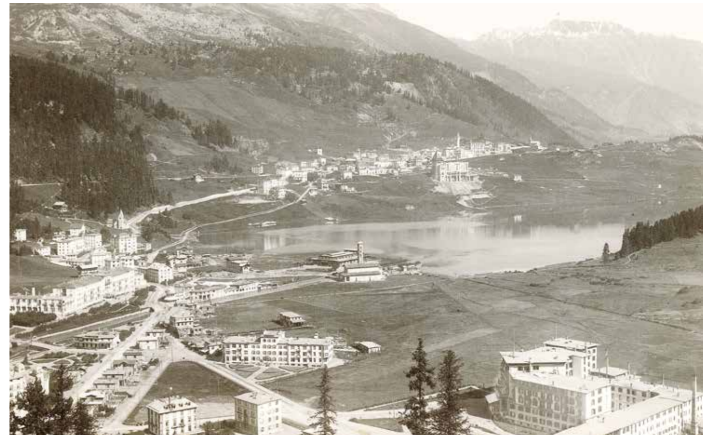
oben Die Stromleitung des Consortiums verbindet das Kraftwerk Silvaplana mit St. Moritz-Bad.
