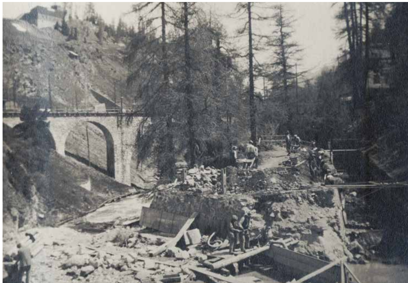
Bau des Zulaufkanals
