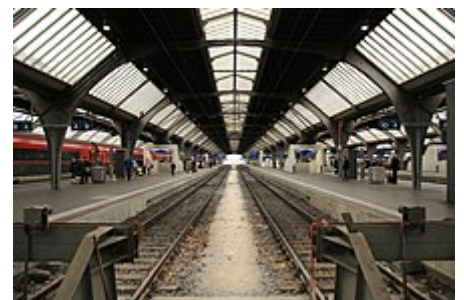
Gleise 9 und 10 in der Gleishalle (2018)
