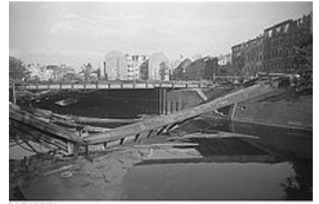
Zustand im Oktober 1945. Im Vordergrund die zerstörte Notkabelbrücke, dahinter die Notbrücke von 1939 vor der beschädigten Potsdamer Brücke
